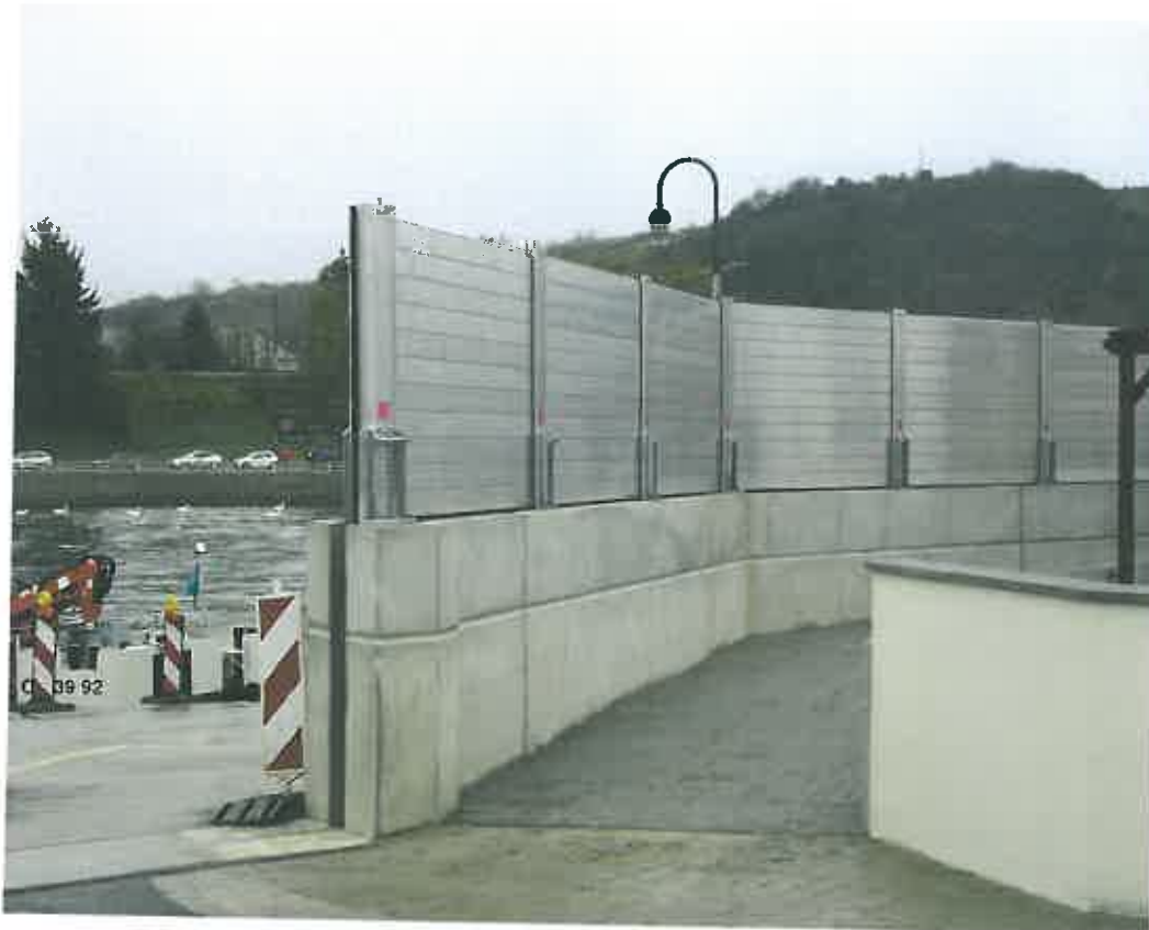
Hochwasserwand mit mobilen Elementen
