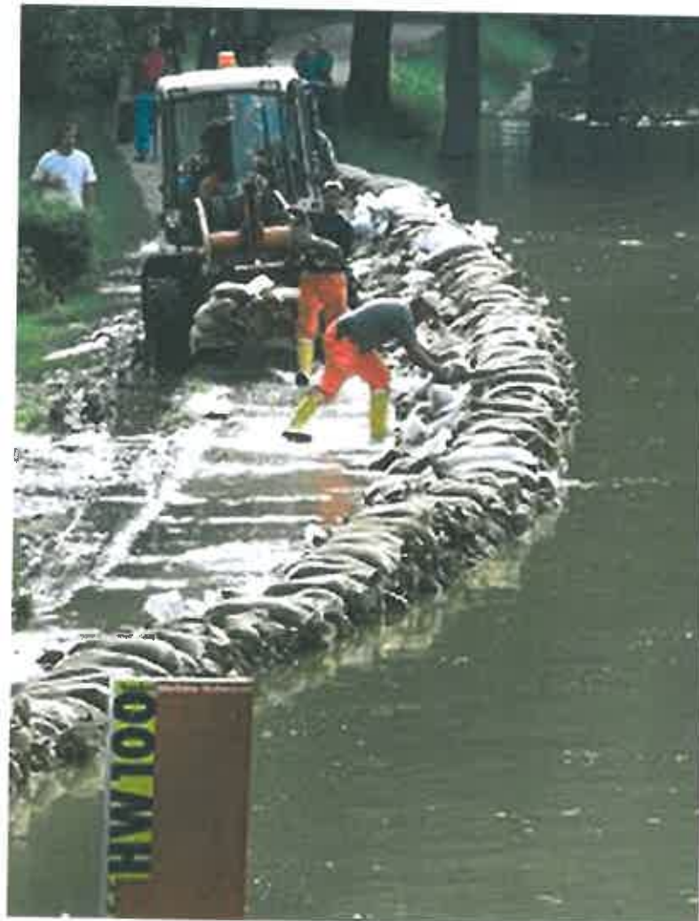
Sandsäcke zur Erhöhung des Oderdeiches. Wenn das Wasser noch höher steigt.....
